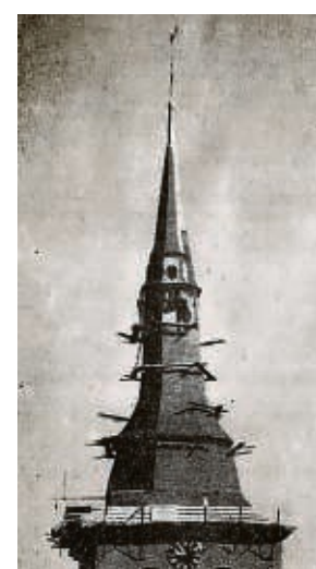
Die Arbeiten am Kirchturm im Oktober 1939.
