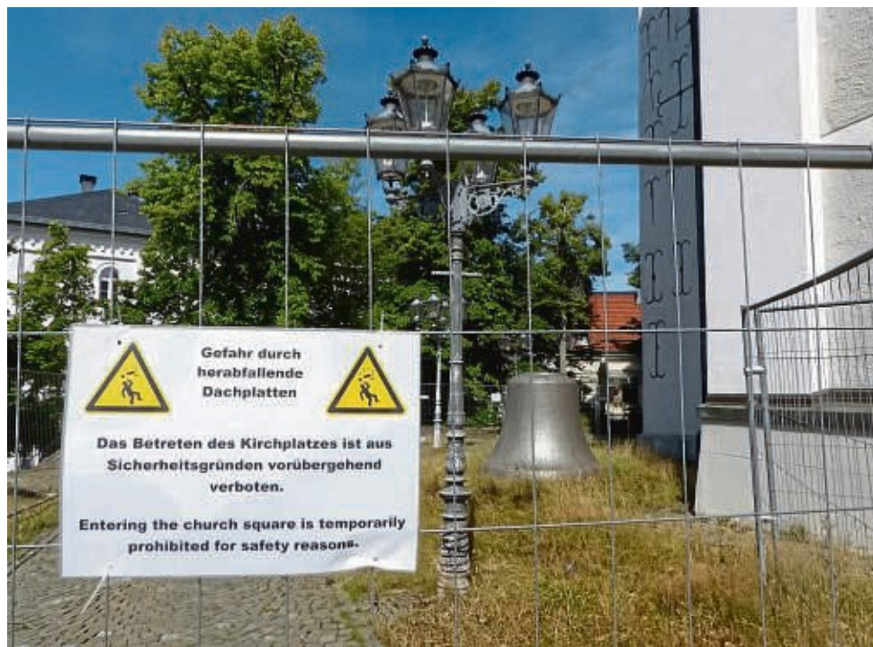
Seit Mitte April ist der Kirchplatz rund um den Erlöserkirchturm aus Sicherheitsgründen gesperrt. Seitdem werden Schadensumfang und Sanierungsaufwand geprüft.
