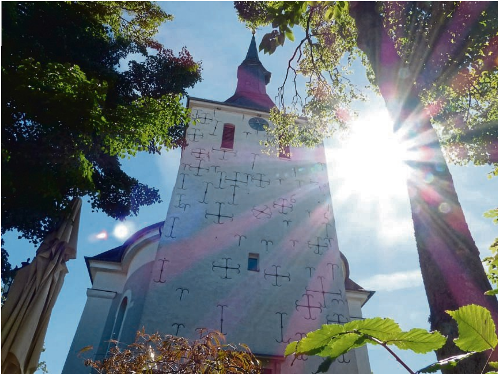
Bis zum Festwochenende Ende September/Anfang Oktober soll ein Auffangnetz den Bereich rund um den Kirchturm sichern.
